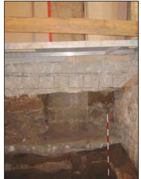
FOTO 4. Vista frontal del pilar UE 07.
