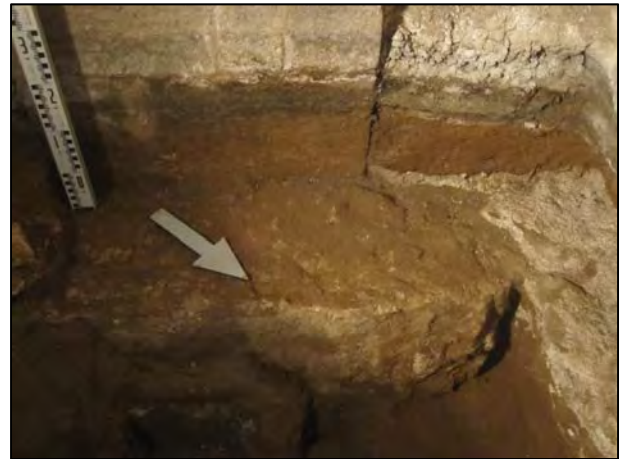
FOTO 6. Fonamentació (UE 08) del pilar de la botiga (UE 07).
